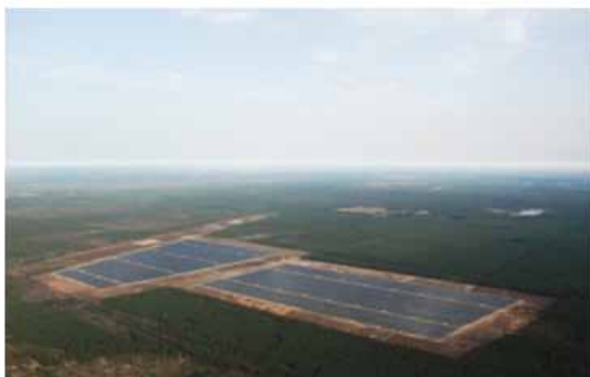
Lieberose Photovoltaic Park, Германия
