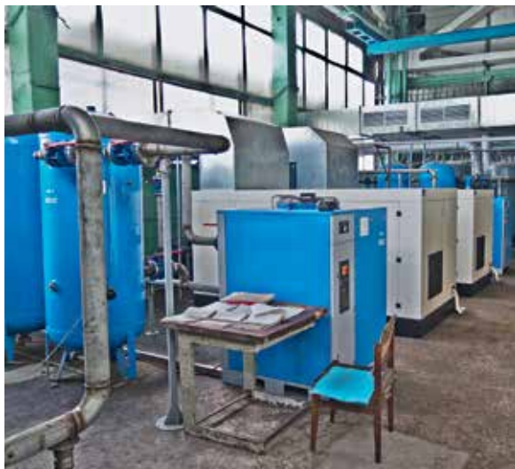
Азотодобывающие станции: две новые (слева); старая (справа). Как говорится, почувствуйте разницу...
