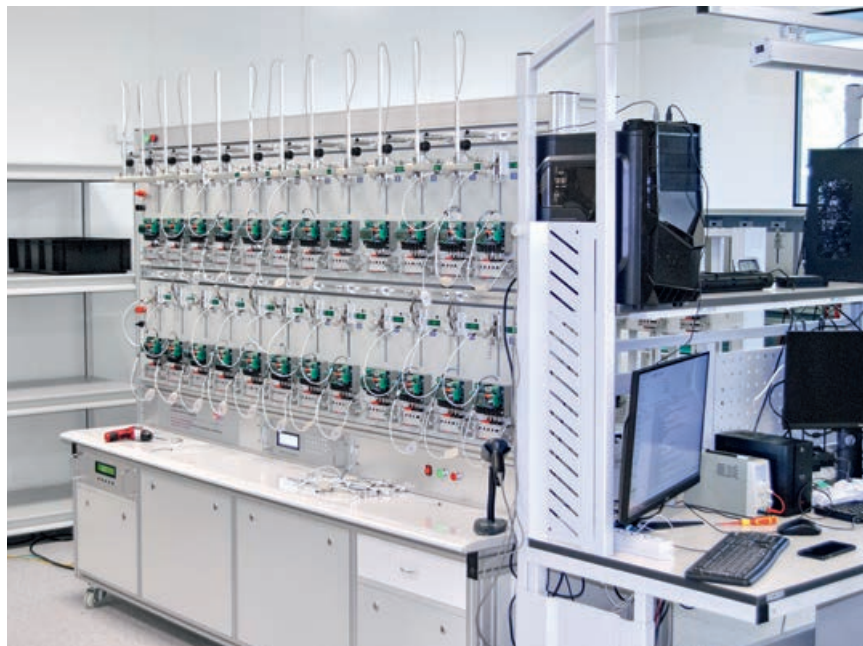
Стенд прогона приборов учета электроэнергии
