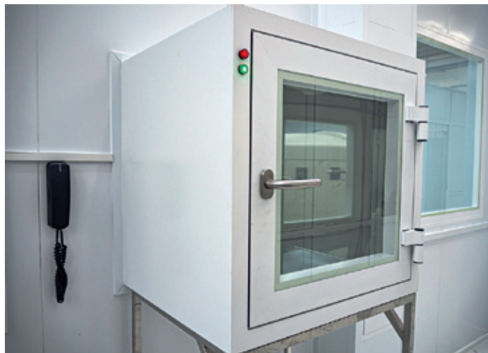
Шлюз для передачи заготовок и изделий в чистое помещение и обратно
